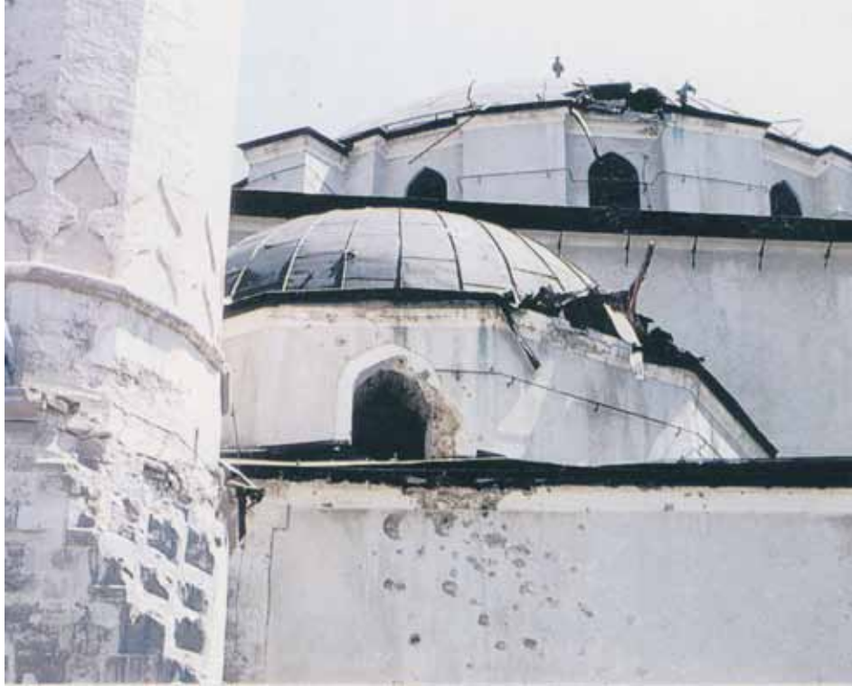
RESİM 12. Bosnia-Herzegovina. Sarajevo – Projectile impacts on the Gazi Husrev Beg Mosque. Bosna-Hersek. Saraybosna – Gazi Hüsrev Bey Camii'ne isabet eden top mermilerinin izleri ve yıkıntıları.
